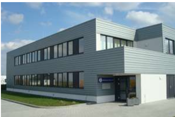
Fotos 36, 37: Instalaciones de IBZ-Salzchemie, Alemania
